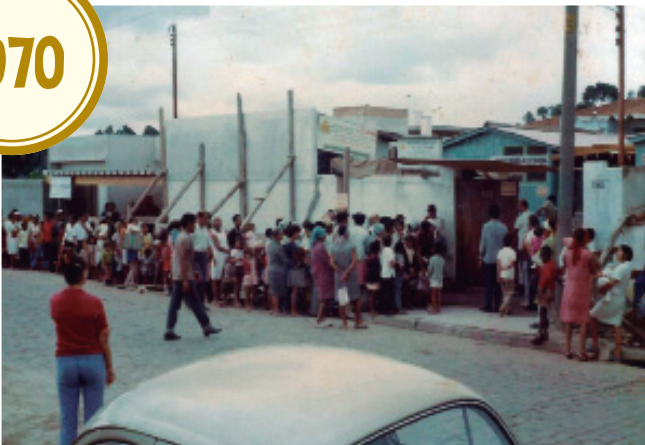
//Fachada da Instituição, ainda em fase de construção, com casas de madeira. Entrega festiva da Campanha de Natal de 1970".
